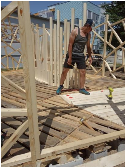
Slika 22: Prekrivanje palet z deskami
